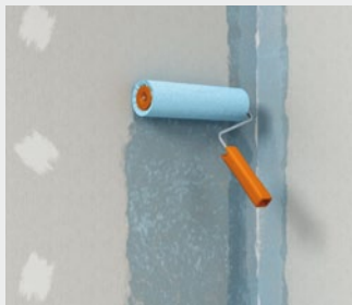
Afb. 18: fermacell Diepgrond aanbrengen op het hele oppervlak
