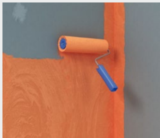
Afb. 23: fermacell Vloeibare folie met de rol 2 x volvlaks aanbrengen (totale dikte \geq 0,5 mm)
