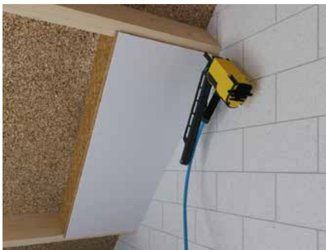
vastzetten hart op hart 100mm
