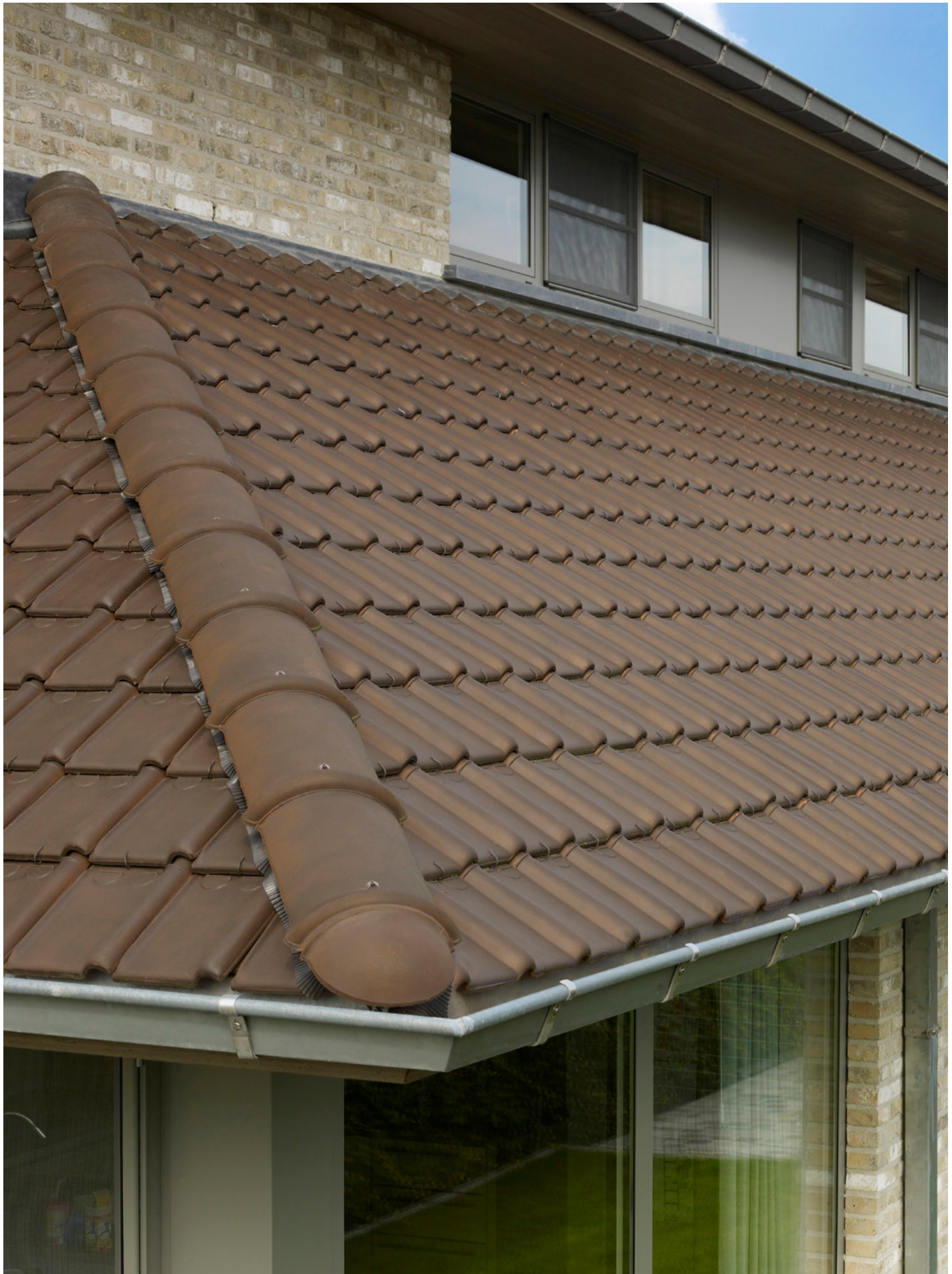
Koramic Stormpan 44 Oud koper: Alu-Rol Extreme onder halfronde vorsten verankerd met inox Torx schroeven met rondel en neopreenring
