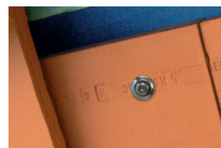
Inox Torx schroef met EPDM-ring 4,5x35 mm voor tegelpannen
