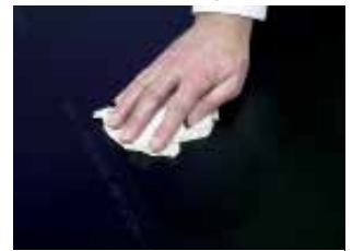
Voorbehandeling achterzijde steni met Easy Clean Wipes
