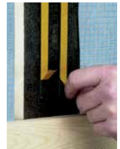
Voorbehandeling achterzijde steni met Easy Clean Wipes
