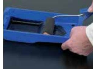
Voorbehandeling houten draagconstructie met Primer SX Black
