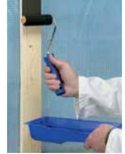
Voorbehandeling houten draagconstructie met Primer SX Black
