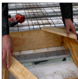
Bekisting en wapening plaatsen
