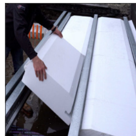
EPS broodjes plaatsen
