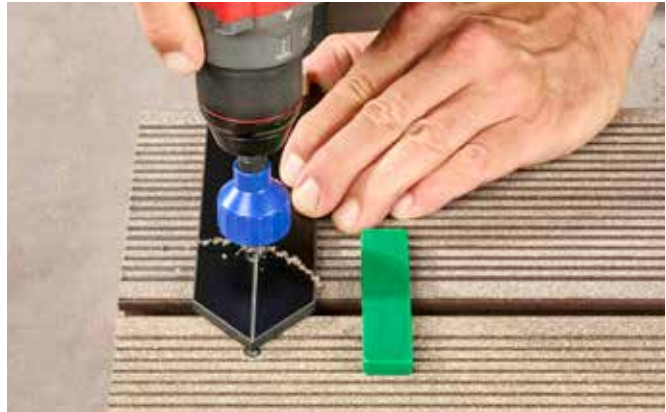
1. Sjabloon in het midden van de onderconstructie leggen en gaten markeren
