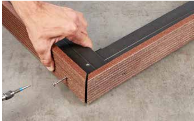
Afwerking met randplank
