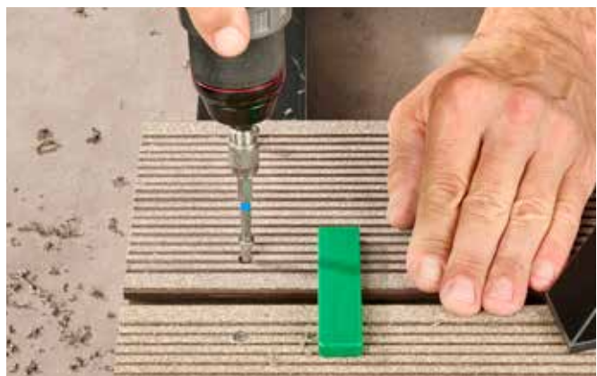
3. Plank vastschroeven
