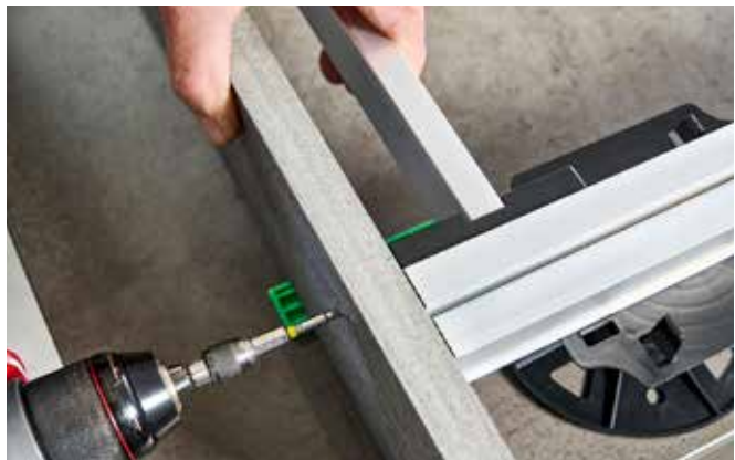
Bevestiging met adapter voor dwarse versteviging
