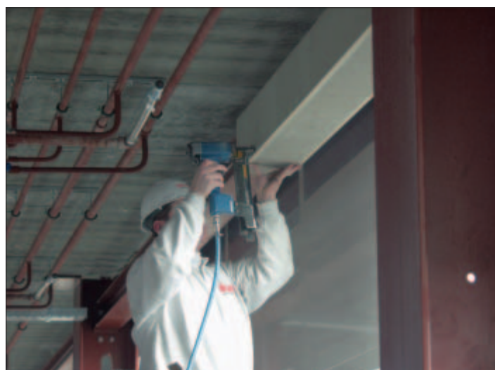
Montage onbrandbare wigklos
