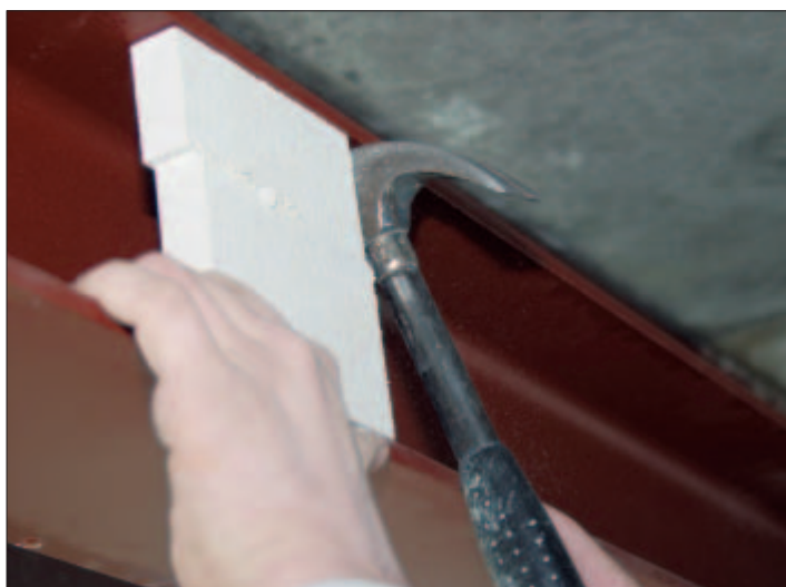
Montage onbrandbare wigklos
