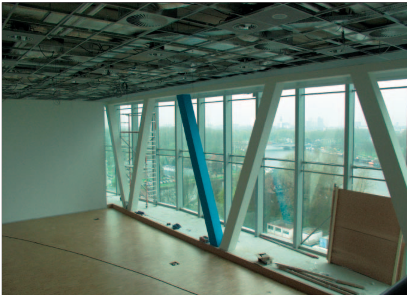
Brandwerend beklede draagconstructie met PROMATECT® -H
