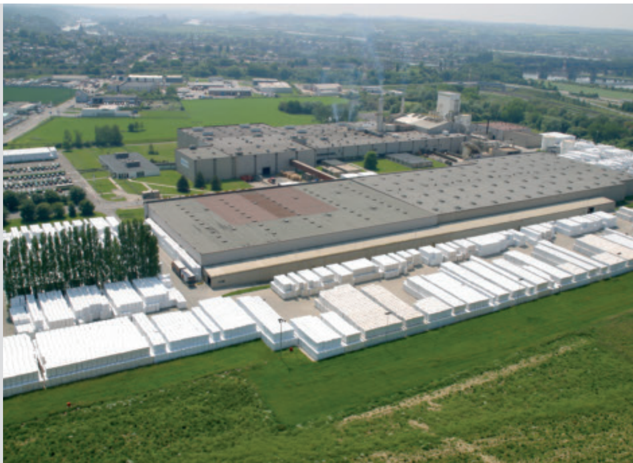
Knauf Insulation Visé
