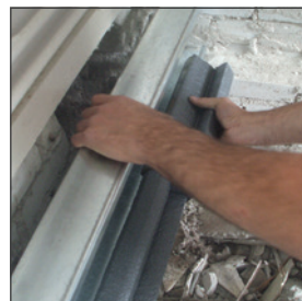
Aanbrengen thermostrip
