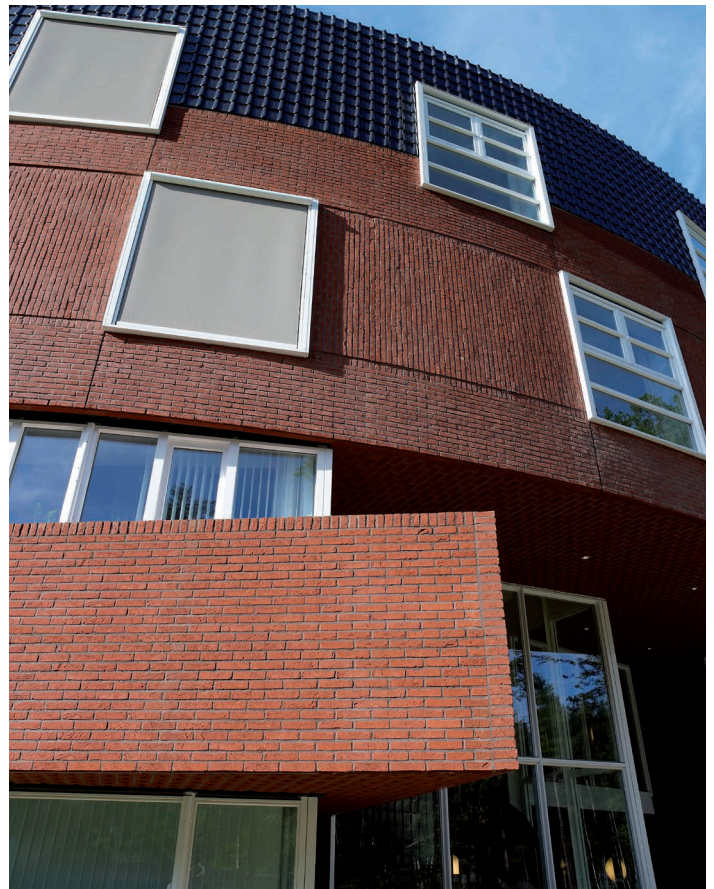
Dilatatievoegen ter plaatse van geveldrager.
