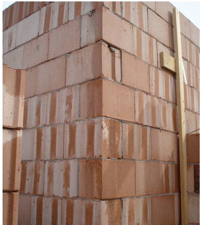
Foto: hoek waarbij de Poriso blokken vertand verwerkt zijn
