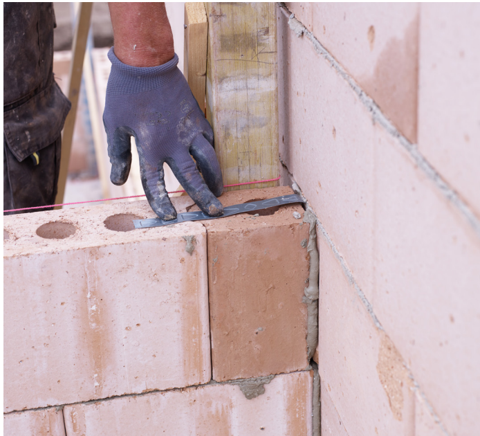
Foto: aansluiting dragende wanden Poriso met lijmstrip + loodvoeg verlijmd
