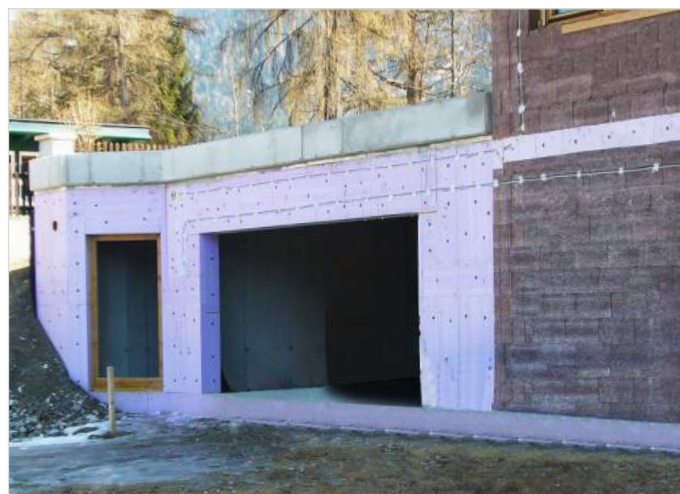
Koudebrugisolatie met JACKODUR® Gefiniert
