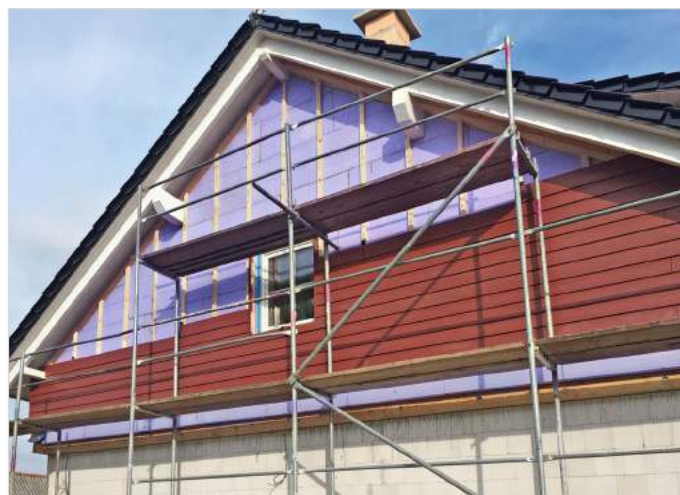
Isolatie achter bekleding met JACKODUR®
