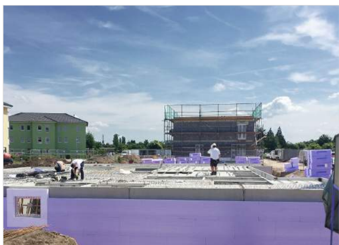
Perimeterisolatie met JACKODUR®
