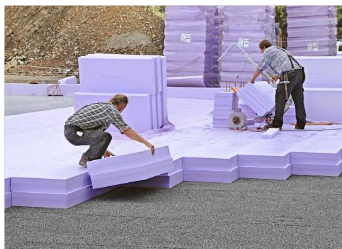
Isolatie onder de vloerplaat met JACKODUR®
