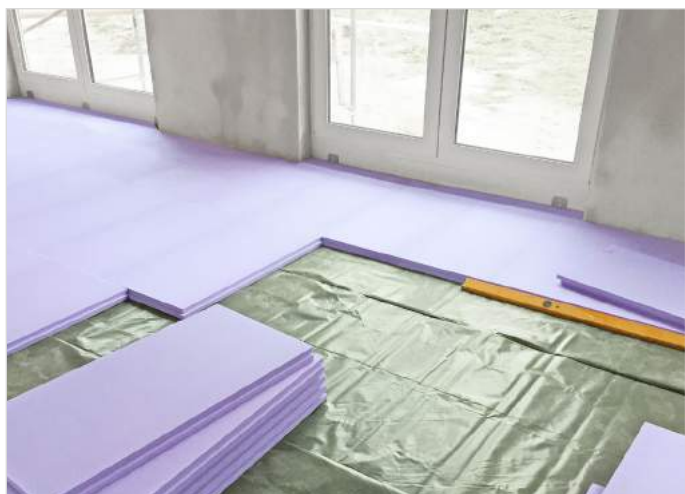
Isolatie onder industriële vloeren met JACKODUR®
