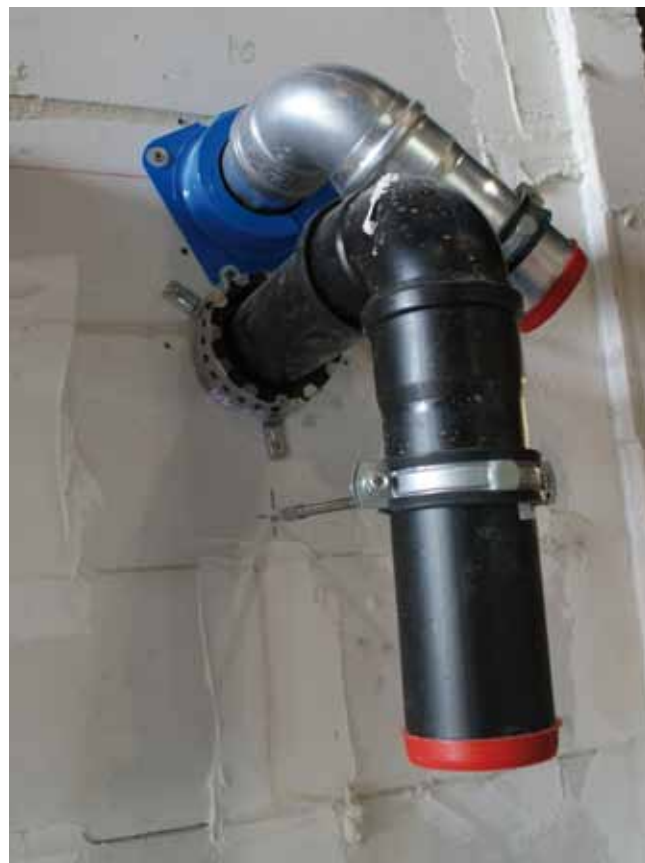
PROMASTOP® -A en PROMASTOP® -U brandmanchetten om de RGA en de VLT-leidingen in de teststelling bij Efectis.
