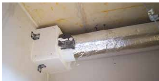
Een uit de wand geplaatste brandklep werd beveiligd met PROMATECT® -L500
