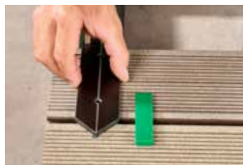
1. Boorsjabloon aanbrengen
