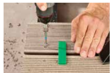
4. Plank vastschroeven
