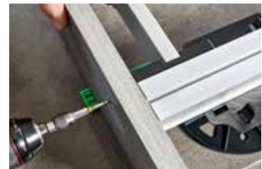
1: Paneelbevestiging met profielversterker zie pag. 28-29
