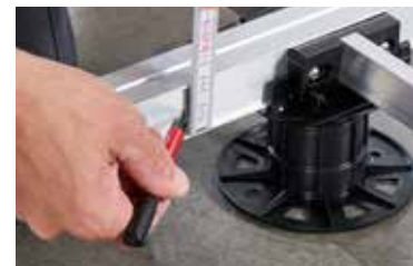
2. Gaten (6 mm) in het midden in de OC boren
