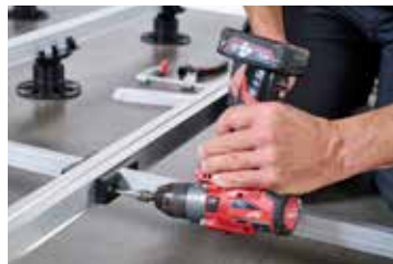
1. Dwarsbalken aanbrengen
